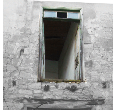
σανιδωτή θύρα εισόδου εντός αυλής με μεγάλο άνοιγμα φεγγίτη
