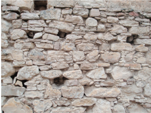
τοιχοποιία με ακανόνιστη διάταξη με χρήση διαφορετικού μεγέθους λίθων
