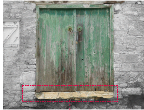
σανιδωτή θύρα εισόδου ελάχιστα πιο ψηλά από το επίπεδο του δρόμου με τοποθέτηση μεγάλων λίθων στο κατώφλι
