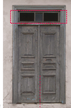
Μεταγενέστερη νταμπλαδωτή θύρα εισόδου σε υψομετρική διαφορά από τον δρόμο
