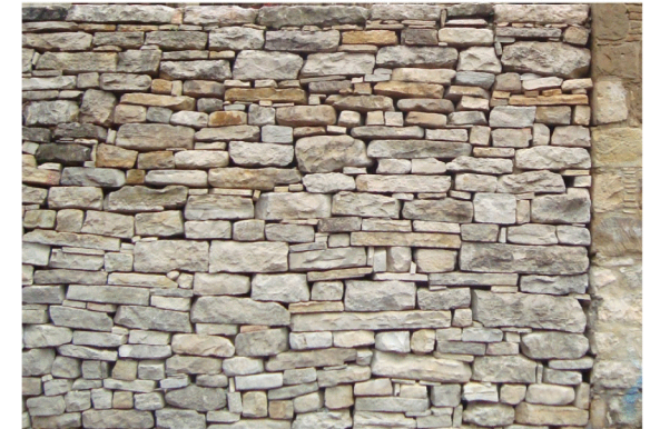
τοιχοποιία με οριζόντια διάταξη διαφορετικού μεγέθους λίθων με πλακοειδής μορφή (χρήση ραμμάτων)
